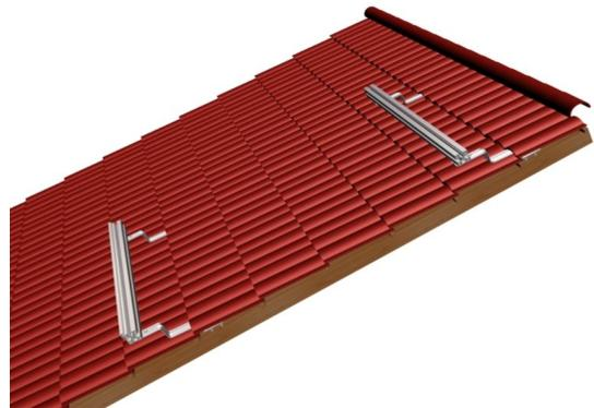
Après le montage des fixation, vérifier l'étanchéité. Si les tuiles ne repose pas correctement, il peut être nécessaire de meuler l'emplacement de la patte pour éviter toute prise au vent
